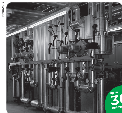
ATV12控制泵站(▲)
